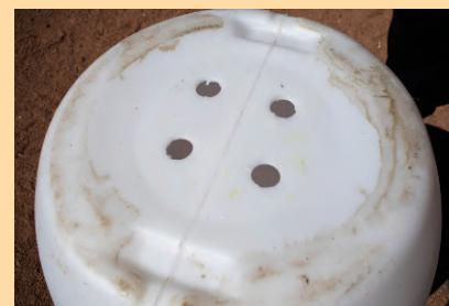
**1** Realizar 4 agujeros en cruz (según ejes perpendiculares), ubicados a la misma distancia del centro de la base de los dos tanques. Es muy importante que coincidan los agujeros del tanque interior y exterior. Para ello se puede usar un papel para "calcar" la ubicación de los agujeros.
