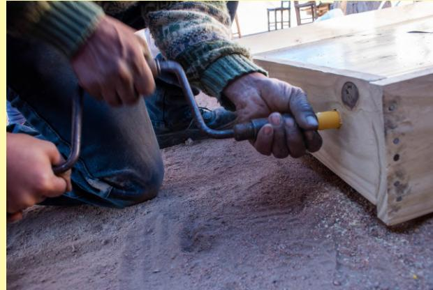
3 Agujerear la estructura cerca de 2 esquinas enfrentadas para hacer la entrada y salida de la manguera del colector.
