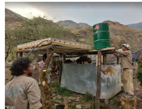
En el caso de no contar con un espacio de ducha ya construido se puede aprovechar la superficie del colector para armar el techo del cuarto de ducha. Para ello será necesario plantar postes que soporten el peso del colector y fijar toda la estructura a ellos. Si el tanque no se instaló a presión deberá colocarlo por encima del colector, si se instaló con presión, el tanque podrá estar ubicado por debajo.
