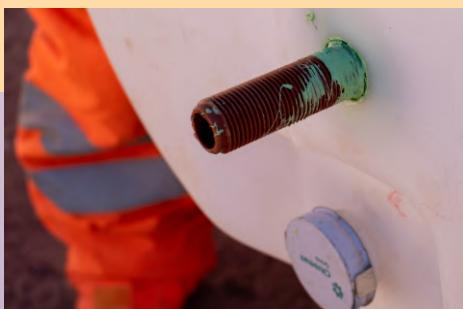
Por último colocar una brida en el agujero superior del tanque. Esta brida nos servirá como purga del sistema y es útil sobre todo en el momento de llenado final del tanque.
