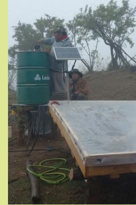
En este caso, se debe anular la entrada de agua fría del calefón (ER), manteniendo cerrada la llave correspondiente, e incorporar agua en el tanque interno de manera manual.
