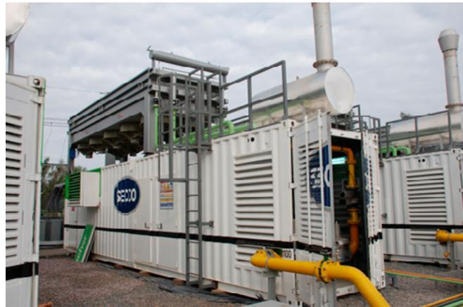
● Planta de generación de energía eléctrica a partir de la utilización del biogás de relleno sanitario.
