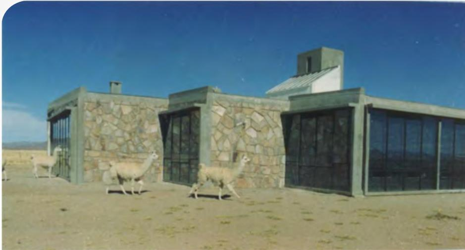
*Vista de los muros Trombe de la casa del INTA en Abrapampa a 3500 m.s.n.m., Jujuy, 1982.*
