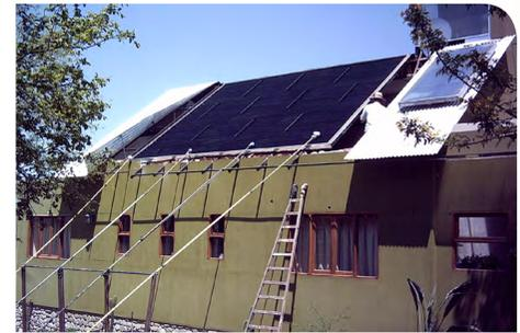
*Construcción del colector solar calentador de aire integrado al techo. Vivienda Samiri, Ciudad de Vaqueros, Salta, 2007.*
