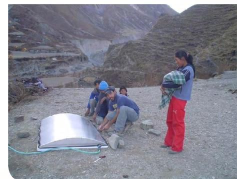
Construcción e instalación de calefones solares de bajo costo (PVC) en San Juan, Iruya, 2006.
