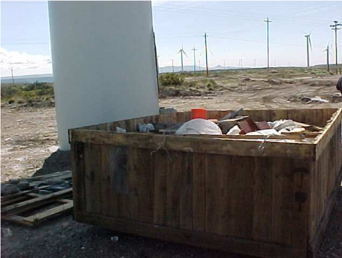
Gestión de residuos durante el montaje de un aerogenerador. Comodoro Rivadavia. Fuente CREE
