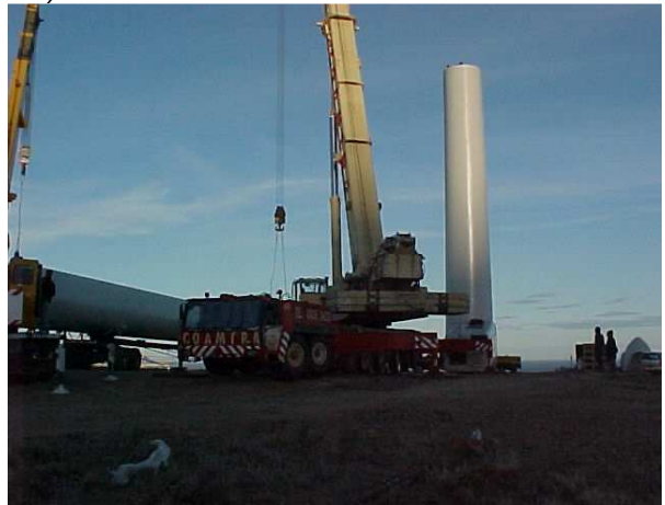
Construcción de la base y traslado de tramos de torre. Registro propio (PE Antonio Morán y PE Jorge Romanutti).
