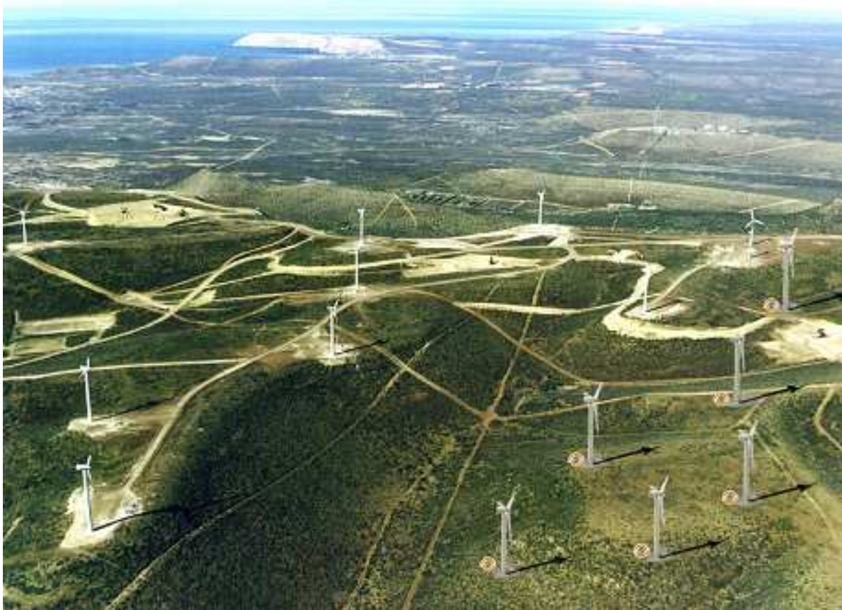
Figura 1.10: Parque Eólico Antonio Morán, Comodoro Rivadavia. [10]
