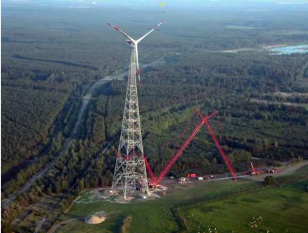
Figura 1.7: la torre eólica más alta del mundo (2009): 160 metros, en Laasow (Alemania). [20].
