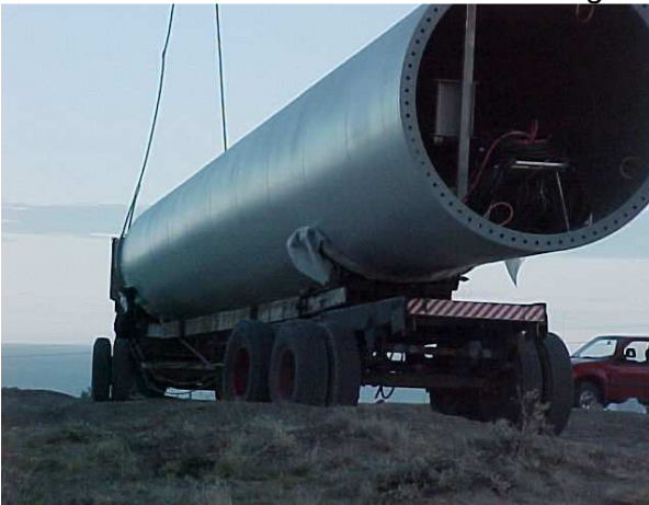
Construcción de la base y traslado de tramos de torre. Registro propio (PE Antonio Morán y PE Jorge Romanutti).
