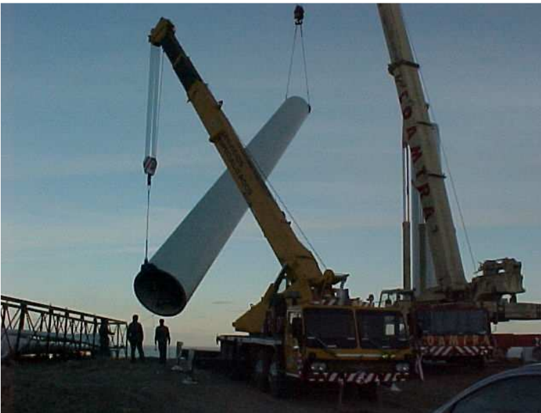
Cada componente requiere para su montaje, de distinto tipo de maquinaria y equipos.
