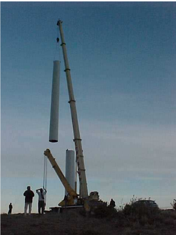
Montaje de una torre. Registro propio (PE Antonio Morán, área "Km 4", C. Rivadavia).
